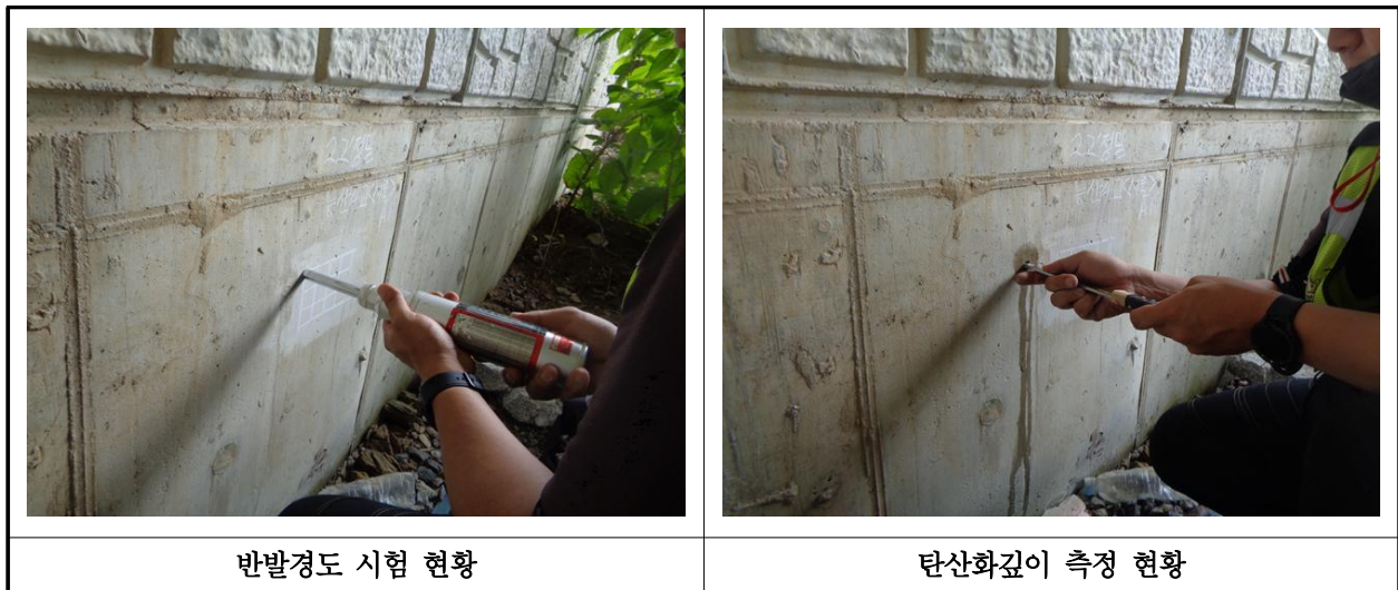
【사진 39.4.1】 콘크리트 내구성조사 현황
