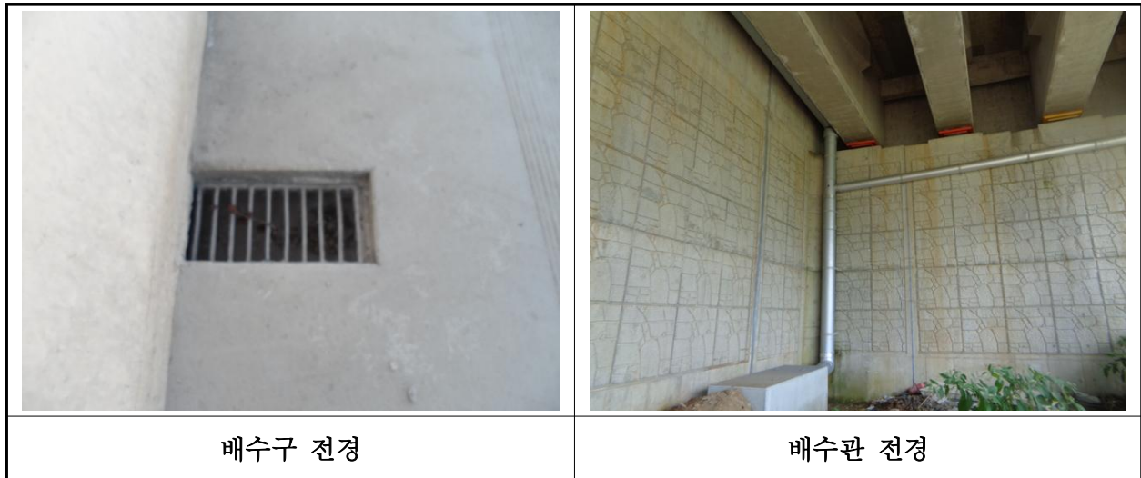
【사진 39.3.21】 배수시설 전경
