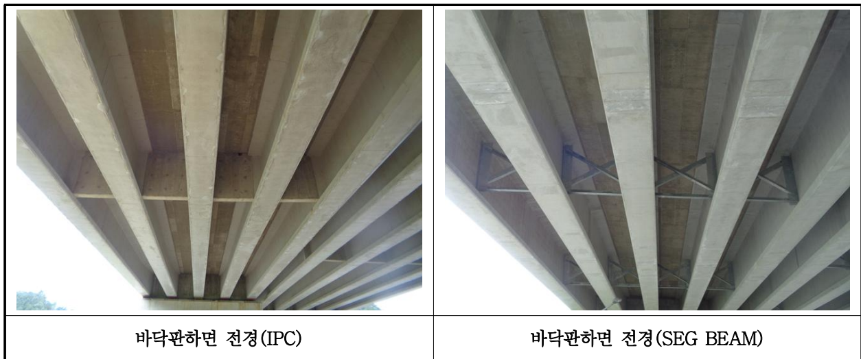
【사진 39.3.2】 바닥판하면 전경
