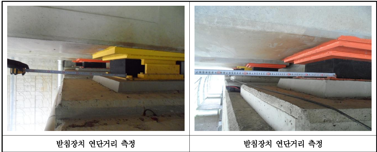
【사진 39.3.14】 교량받침장치 연단거리측정
