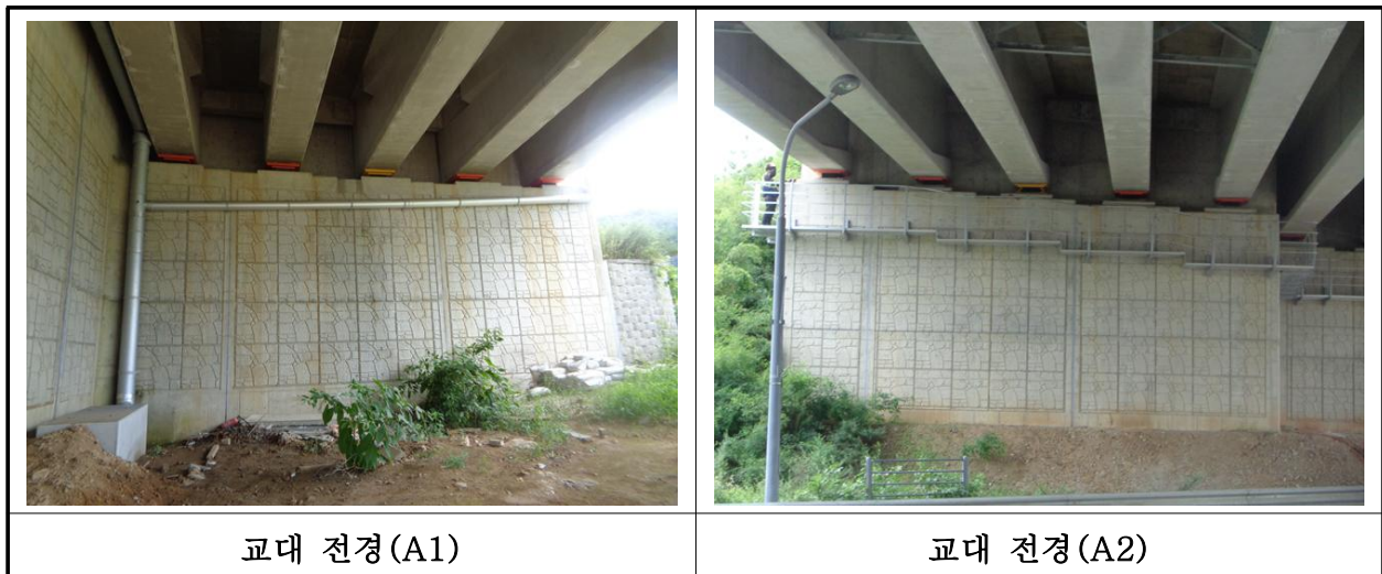
【사진 39.3.8】 교대 전경
