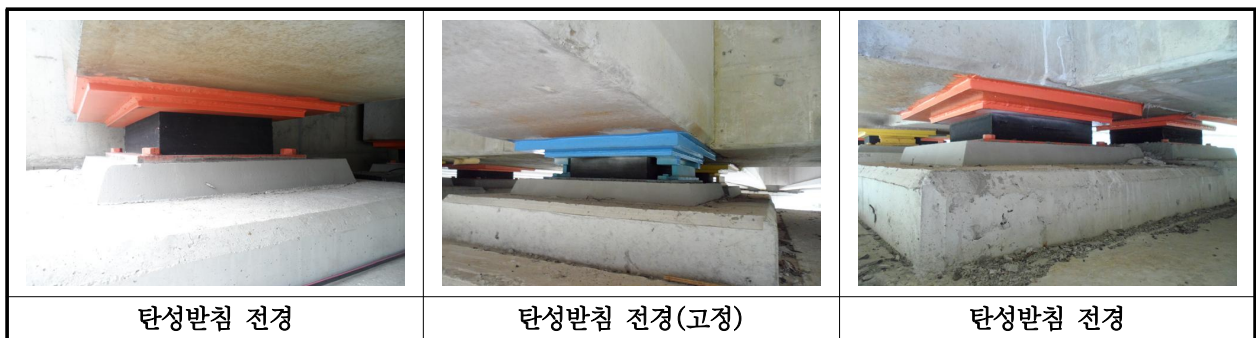
【사진 39.3.12】 교량받침 전경
