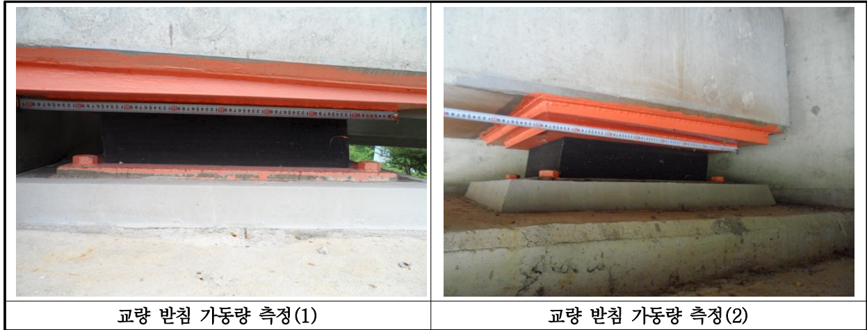
【사진 39.3.15】 교량받침 이동량 측정
