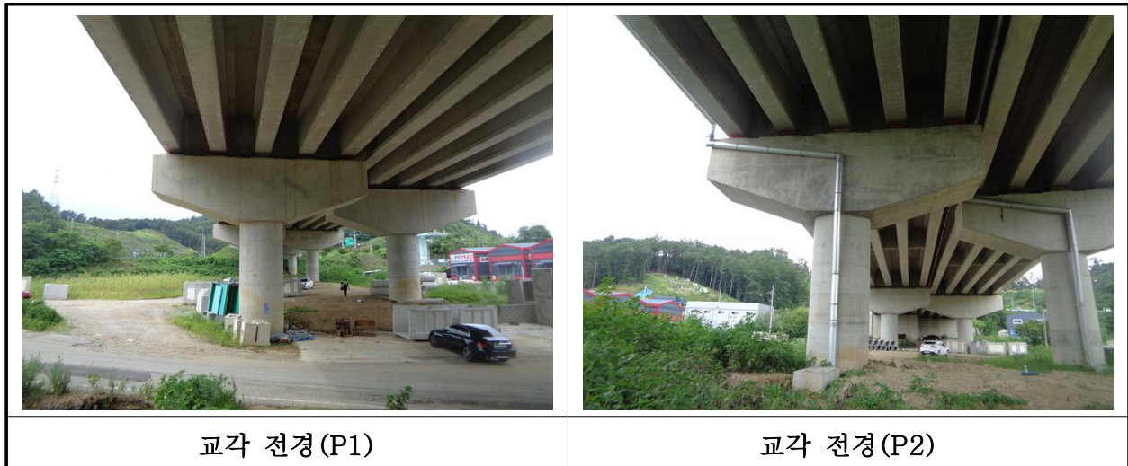
【사진 39.3.10】 교각 전경
