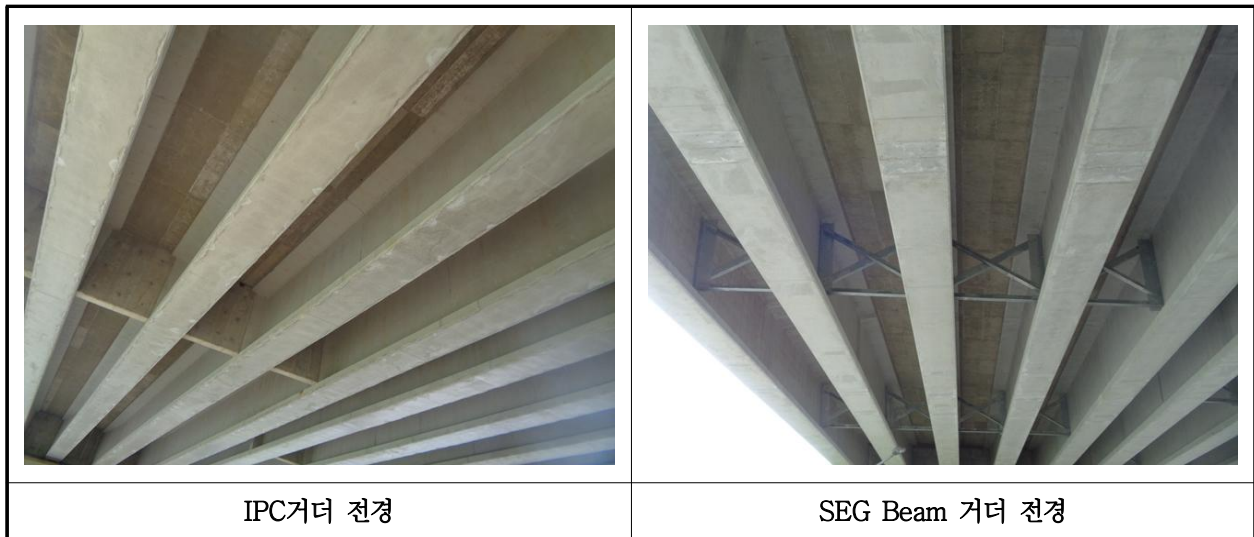
【사진 39.3.4】 거더 전경
