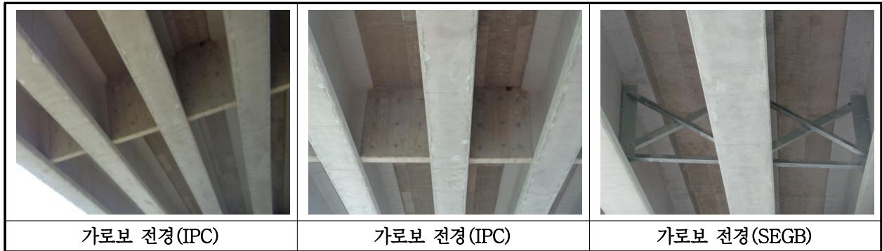
【사진 39.3.6】 가로보 전경
