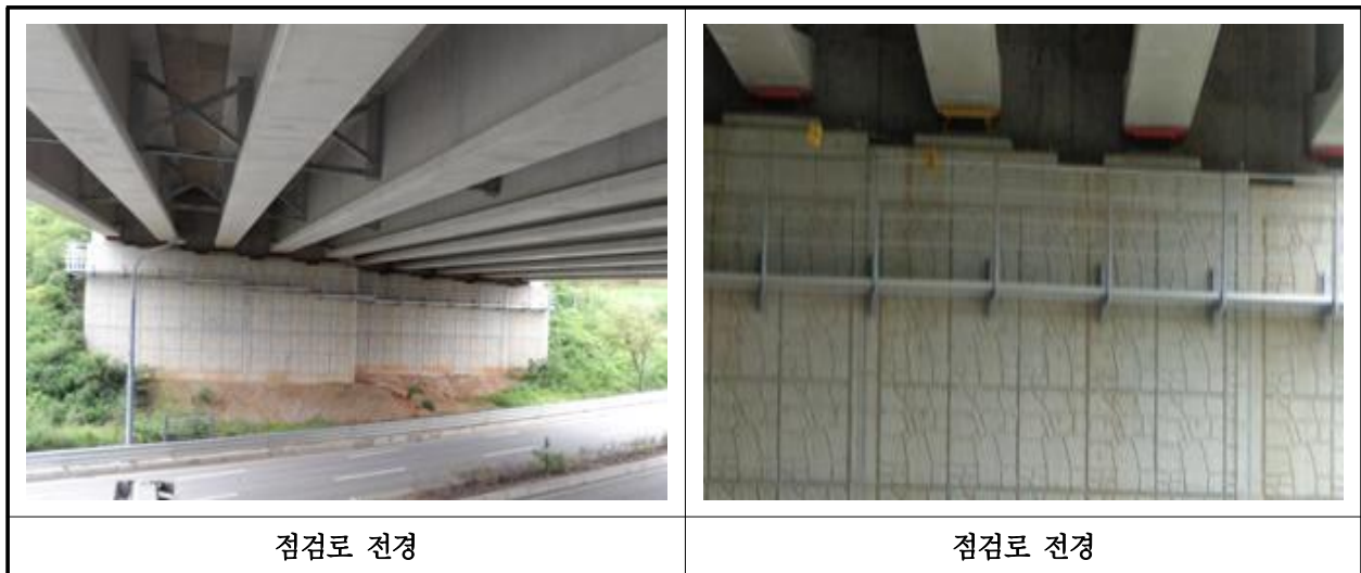
【사진 39.3.25】 교량 점검시설 전경
