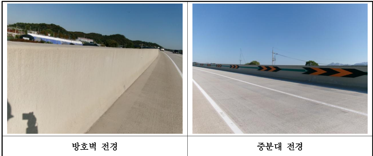
【사진 39.3.23】 방호벽 및 중앙분리대 전경
